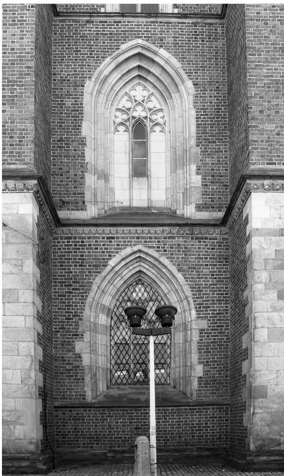
10. Wrocław, katedra, dolne kondygnacje wieży północnej. Fot. J. Adamski Wrocław, Cathedral, lower storeys of the north tower. Photo: J. Adamski
