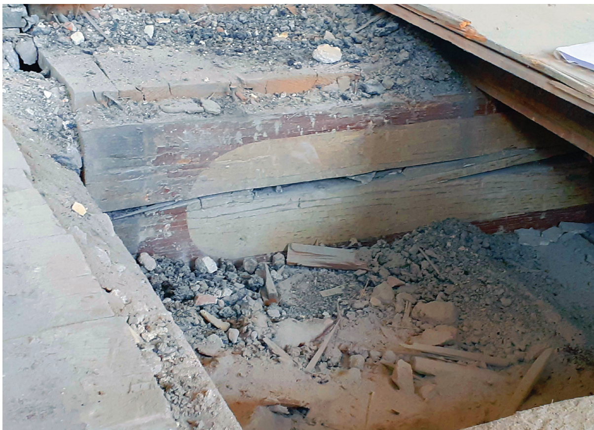
6. Dawny pałac książąt legnicko-brzeskich, belki stropowe nad drugą kondygnacją. Fot. A. Seidel-Grzezińska, 2024
