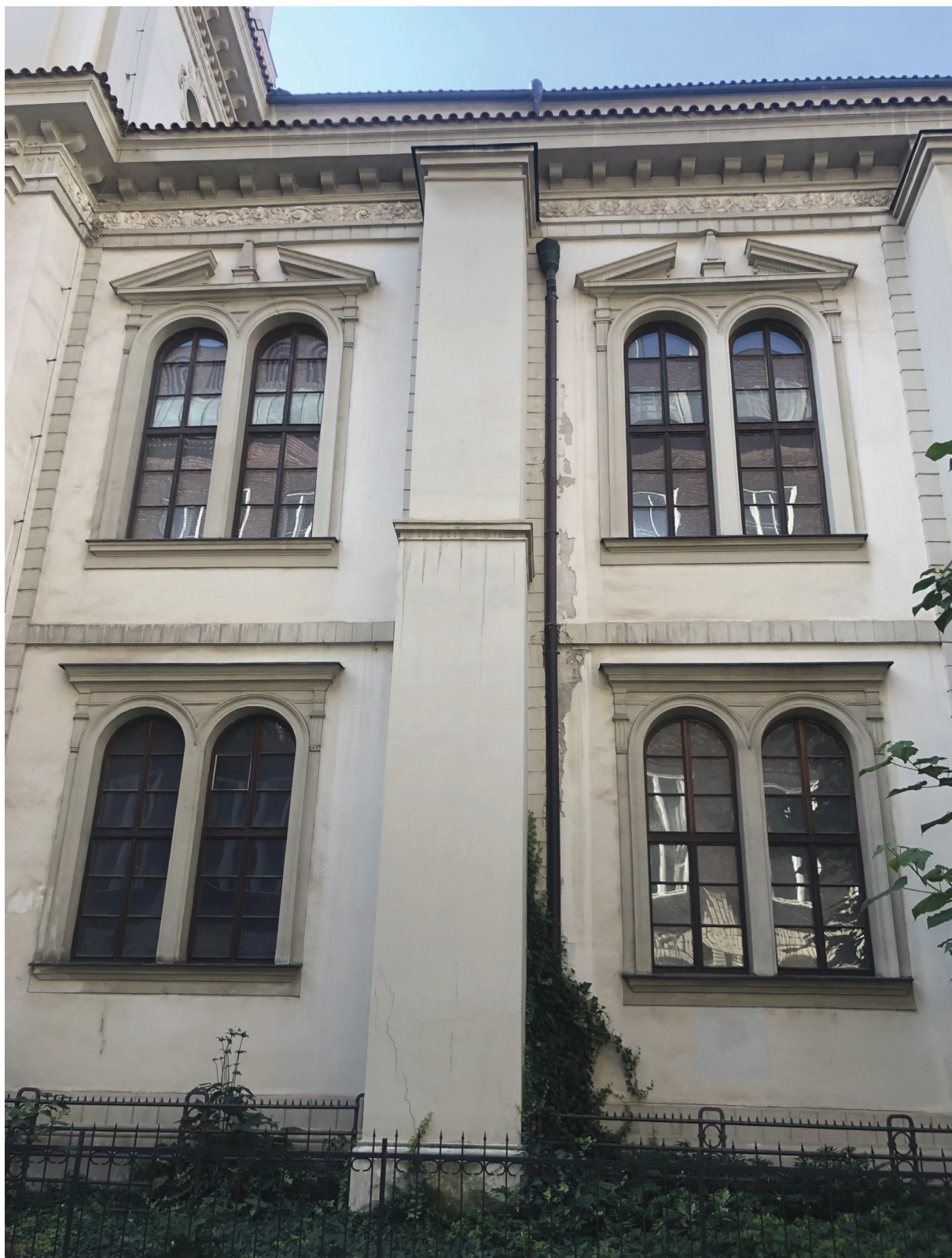
12. Giovanni Maria Filippi (?), kościół luterański pw. św. Salwatora w Pradze, elewacja południowa, 1611-1614. Fot. K. Nalezińska Giovanni Maria Filippi (?), St. Salvator Lutheran Church in Prague, south elevation, 1611-1614. Photo: K. Nalezińska
