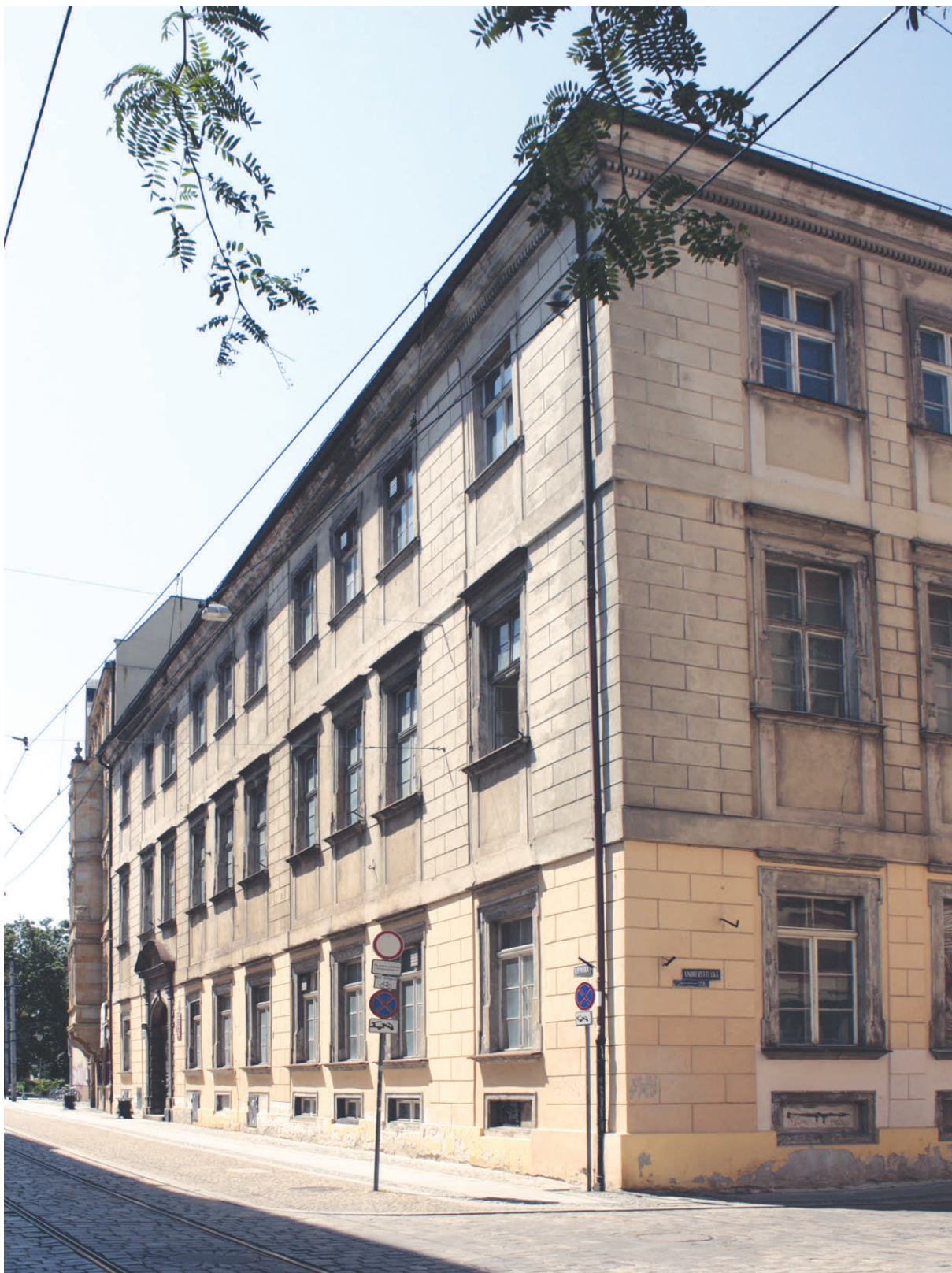
1. Dawny pałac książąt legnicko-brzeskich, widok od północnego wschodu. Fot. A. Seidel-Grzezińska, 2024 Former palace of the Dukes of Legnica and Brzeg, view from the north-east. Photo: A. Seidel-Grzezińska, 2024
