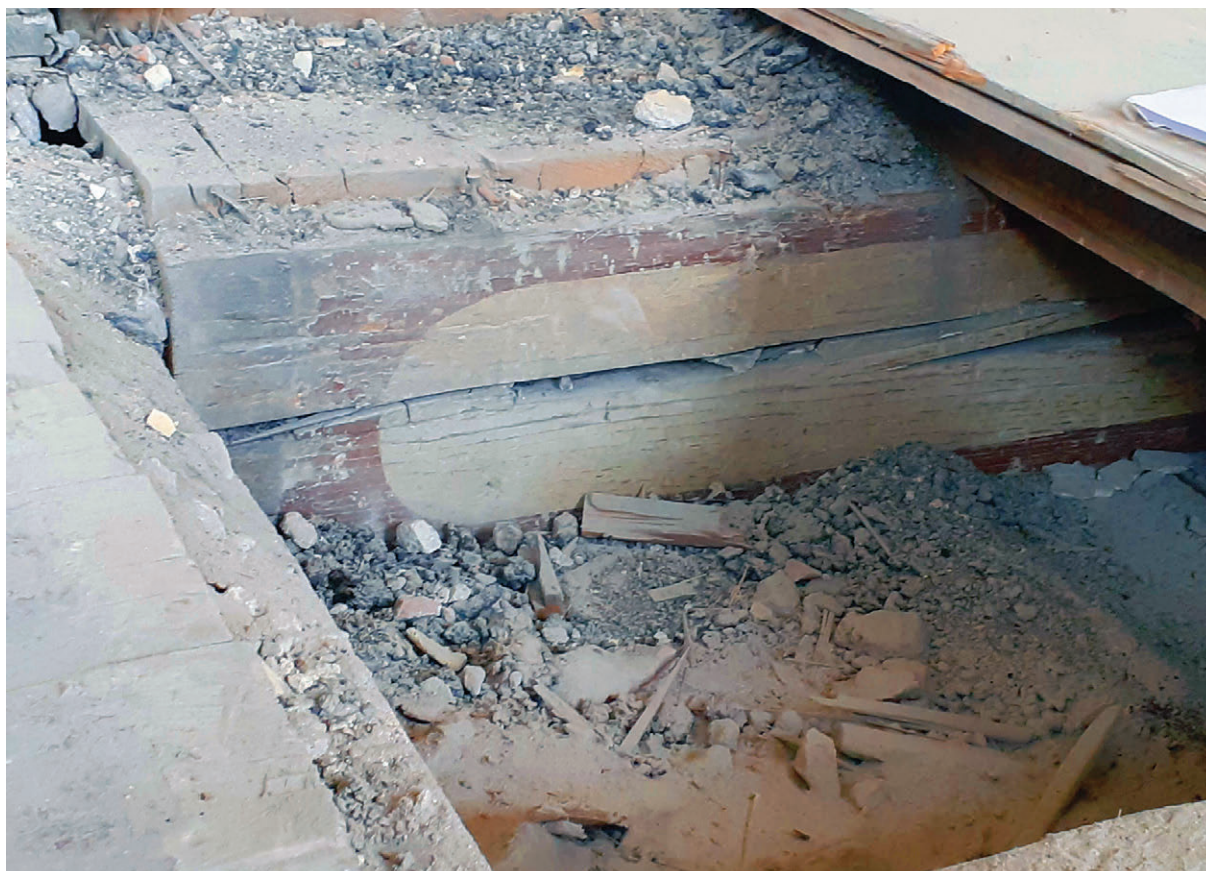
6. Dawny pałac książąt legnicko-brzeskich, belki stropowe nad drugą kondygnacją. Fot. A. Seidel-Grzejska, 2024
