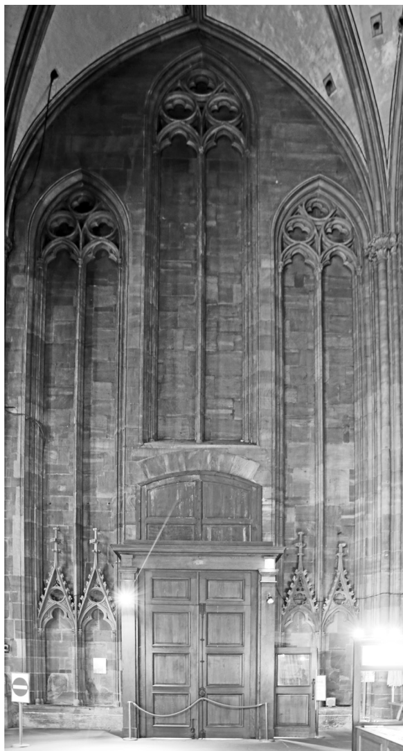
16. Strasbourg, katedra, zachodnia ściana kruchty pod wieżą północną. Fot. J. Adamski Strasbourg, Cathedral, west wall of the porch under the north tower. Photo: J. Adamski
