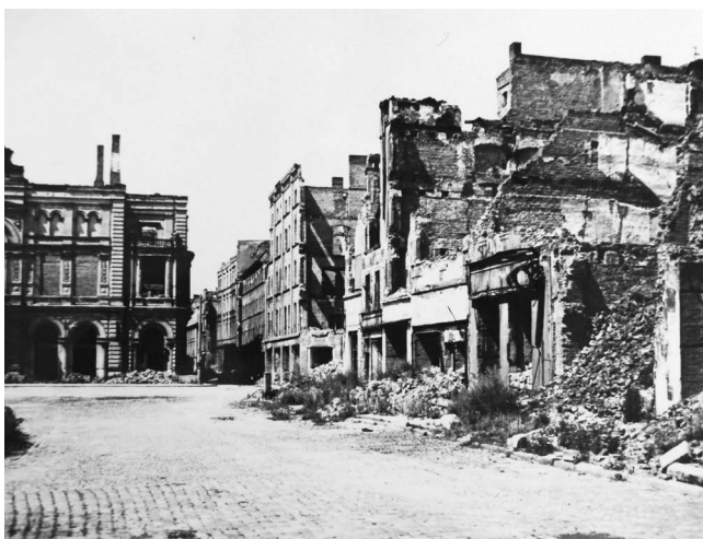
I.2. Zniszczenia w Ryнку i przy ul. Henryka Siemiradzkiego, lata 40./50 XX w.
