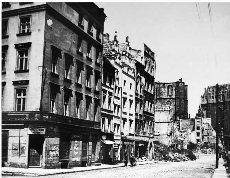
I.21. Południowa pierzeja zabudowy śródmiejscowej, lata 40./50. XX w. (przed 1957 r.).
