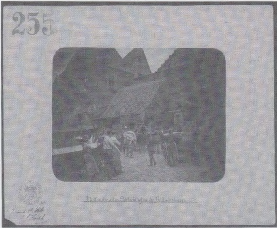
1. Stara rzeźnia miejska, widok od strony ul. Rzeźniczej, fot. Biblioteka Uniwersytecka we Wrocławiu, Oddział Zbiorów Graficznych
